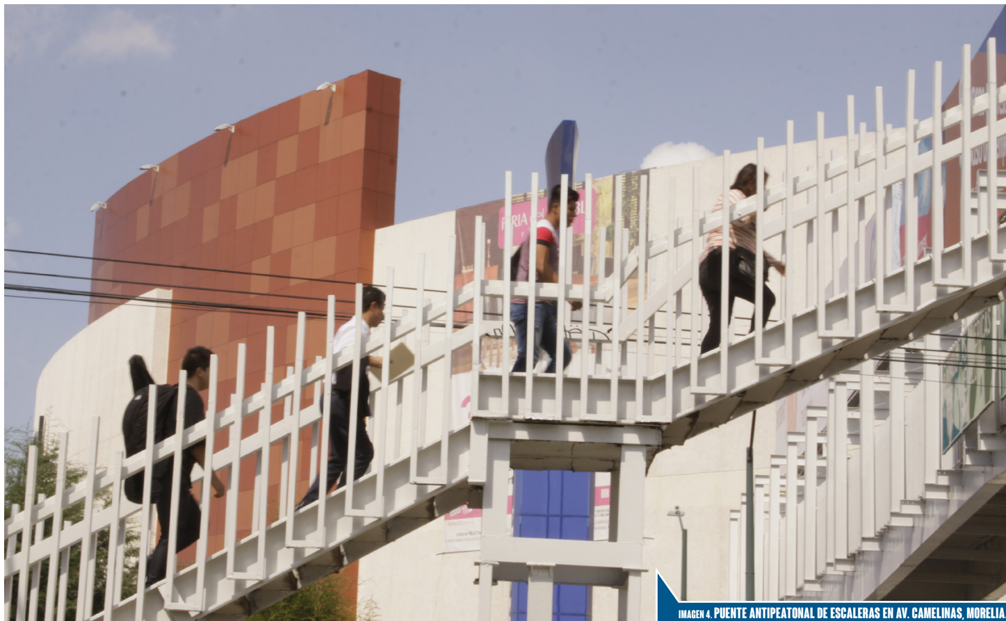
IMAGEN 4. PUENTE ANTIPEATONAL DE ESCALERAS EN AV. CAMELINAS, MORELIA.
