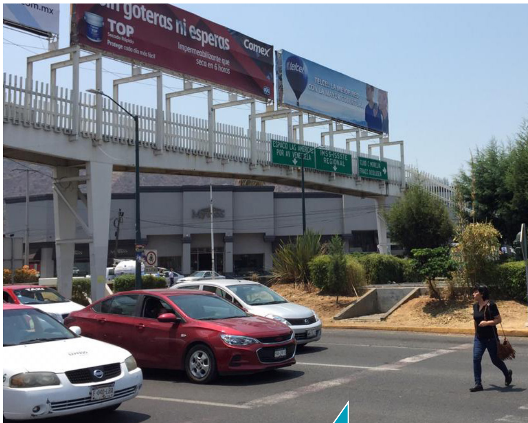
IMAGEN 10. PUENTE ANTIPEATONAL PRÓXIMO A INTERSECCIÓN SEMAFORIZADA EN AV. CAMELINAS, MORELIA.
