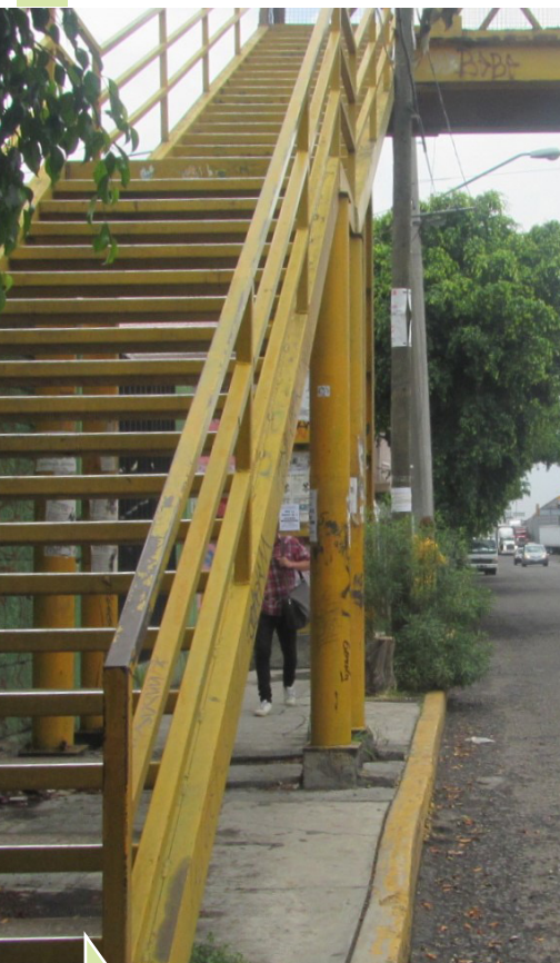
IMAGEN 14. P. ANTIPEATONAL OBSTRUYENDO BANQUETA EN LIBRAMIENTO NTE, MORELIA.
